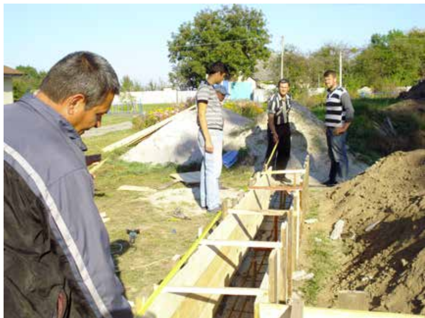
Тому і опалубка під фундамент готова
