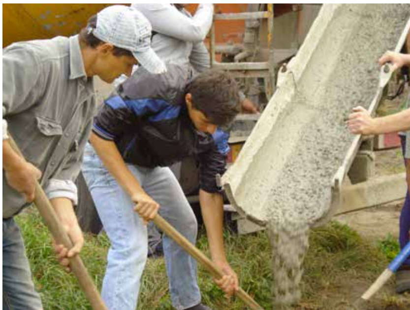
І бетон заповнює траншею
